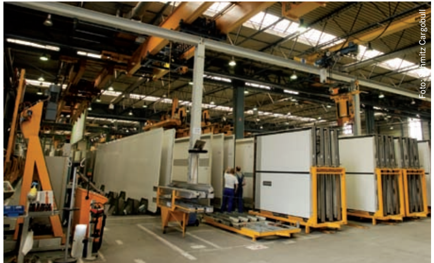
Bild 1: Bis zu 80 Kofferaufbauten werden bei Schmitz Cargobull im Werk Vreden pro Tag gefertigt. Der komplett nietfreie Aufbau der Großpaneele erfolgt mittels einer strukturellen Klebtechnik und unter Einsatz von Plasmatechnik.
